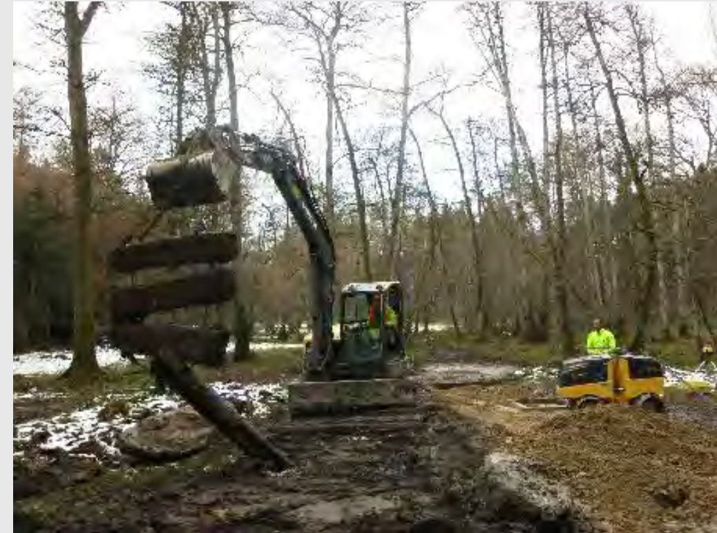
Comblement d'un fossé de drainage dans l'Egelmoos(AG). Photo : Marianne Rutishauser, Pro Natura AG.
