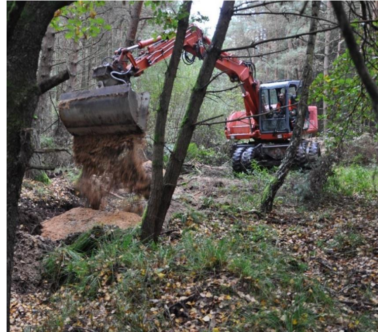
© NGP Bienenwald: Grabenverschluss durch Bagger
